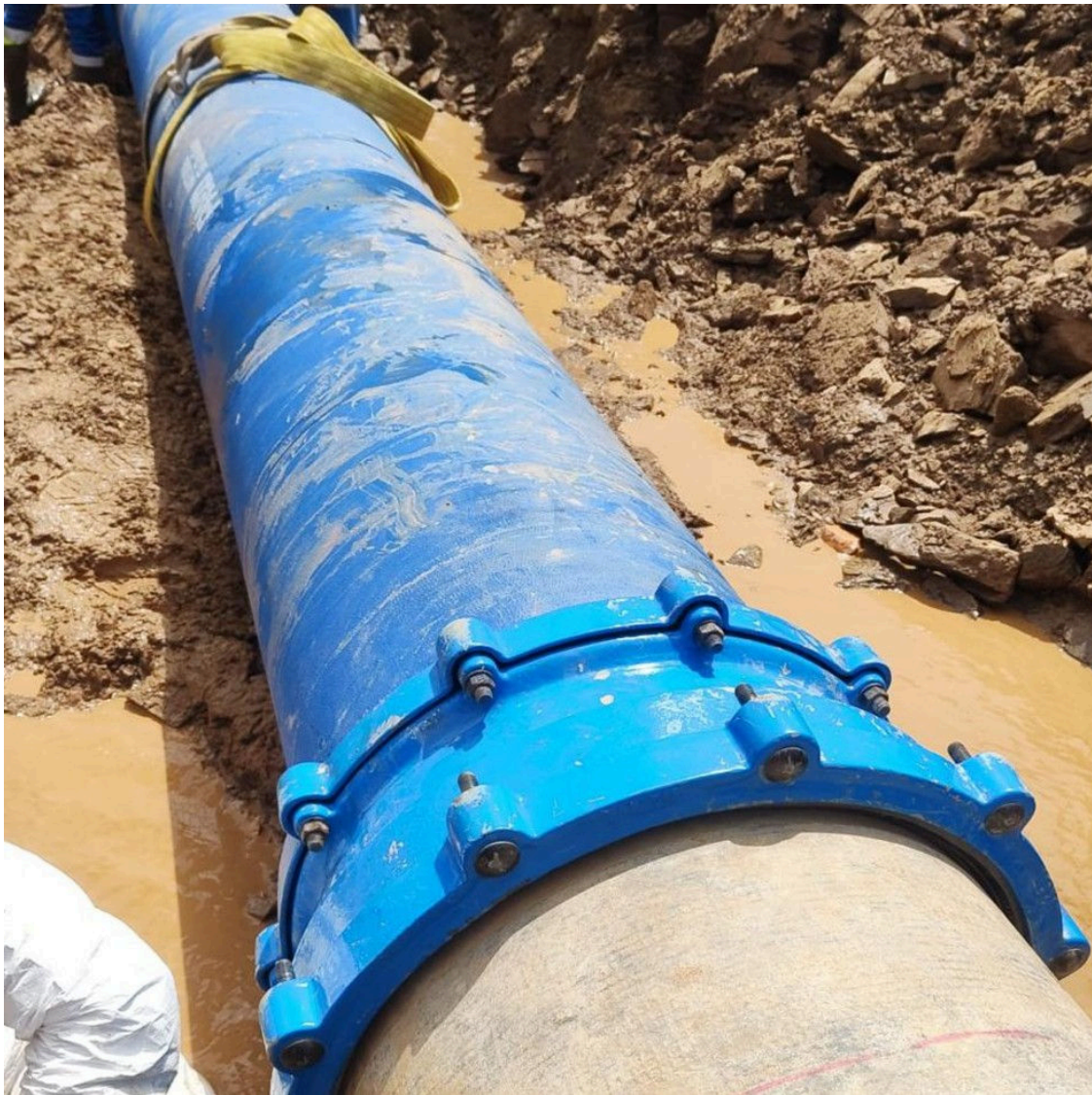
Reparación de la tubería de abastecimiento averiada.
