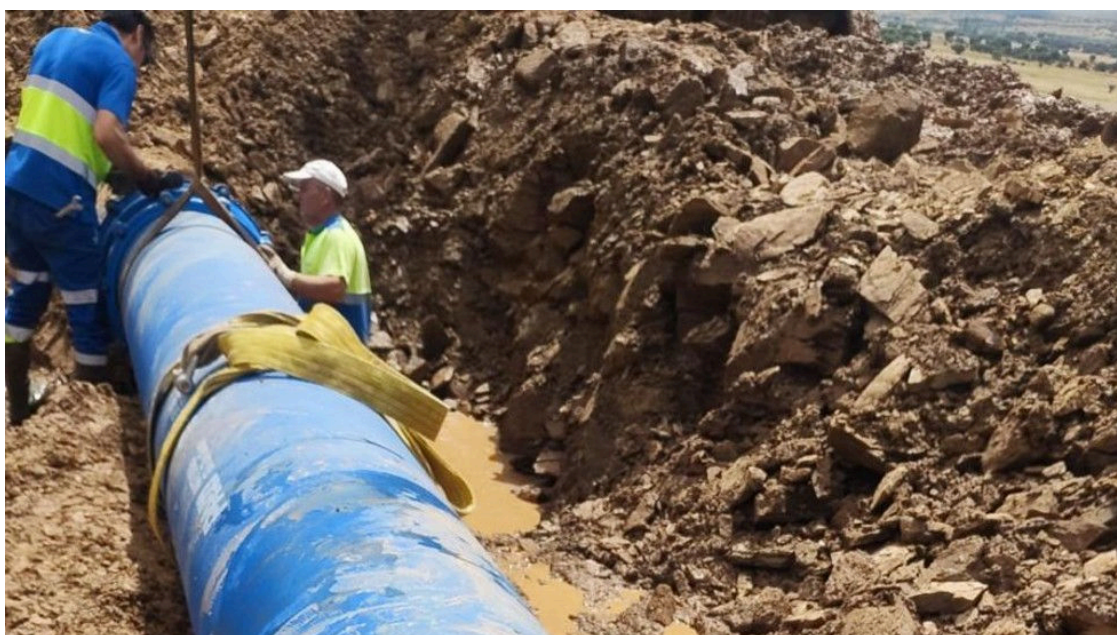
Reparación de la tubería de abastecimiento averiada.
